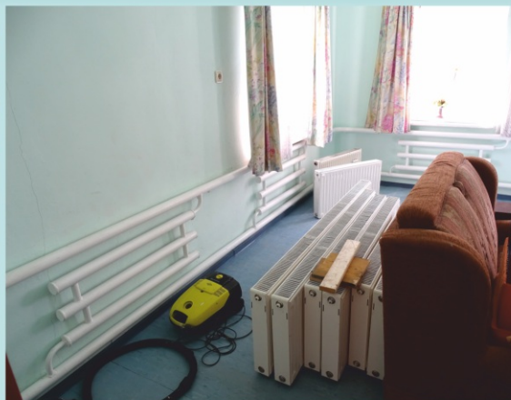
Heizungsreparatur im Mitarbeiterhaus
