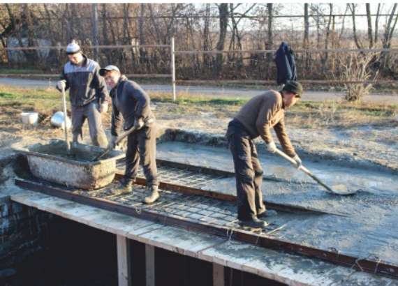
Rehabilitanten bauen eine neue Klärgrube
